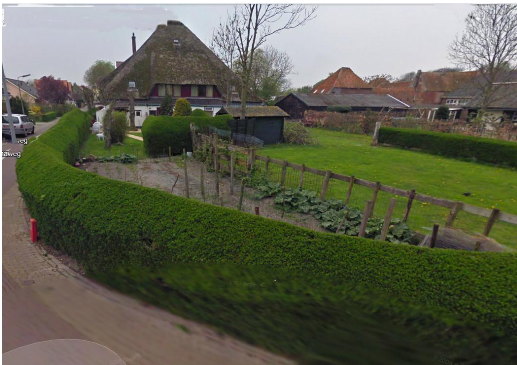
Afb 2. De situatie in 2009 op de hoek van de Julianaweg en de Weg naar de Oude Veert.
