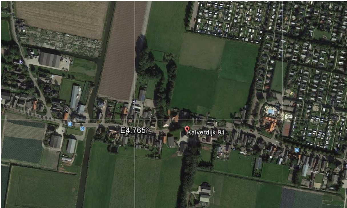
Afb. 2. De situatie voor de sloop
