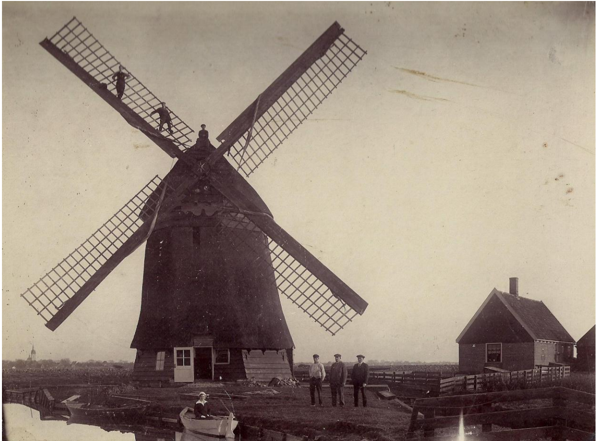
Afb 10 De enige foto van de molen waarin kort hiervoor (1914) een motorgemaal was geplaatst. De molenaar heeft de molen in de zogenaamde 'lange ruststand' gezet, ten teken dat de molen niet langer functioneerde. xvii
