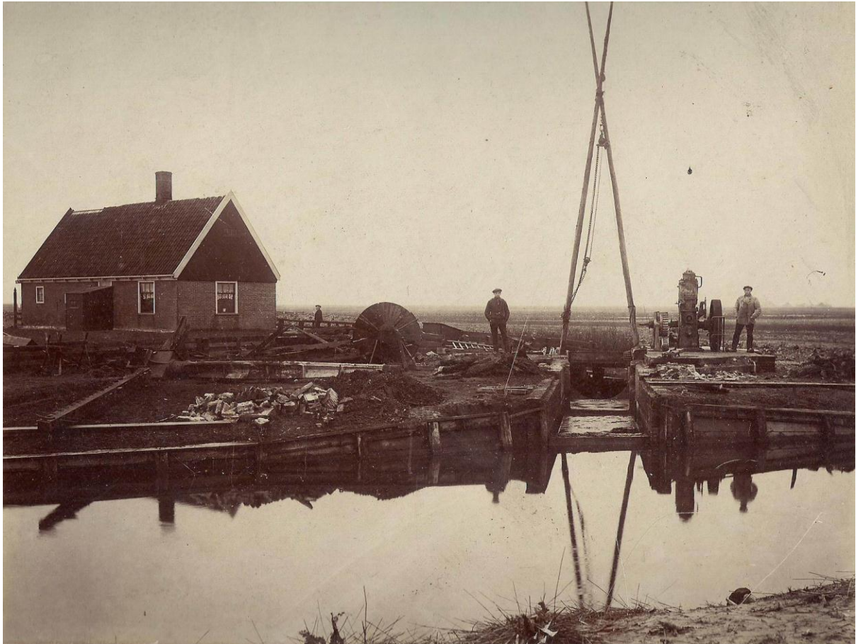
Afb 11 In December 1914 is de molen afgebrand en op deze foto is men bezig de watergangen weer vrij te maken en is de beschadigde vijzel op de kant gehesen. De machine staat nog op zijn plaats en had weinig schade opgelopen.
